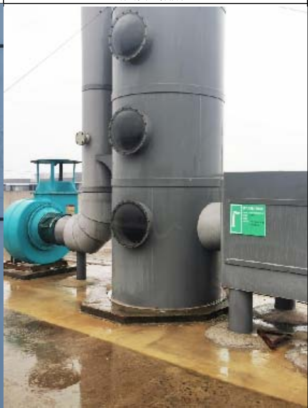
1#实验室废气排放口
