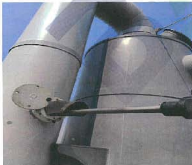
G11 实验室废气处理措施后 DA004-2
