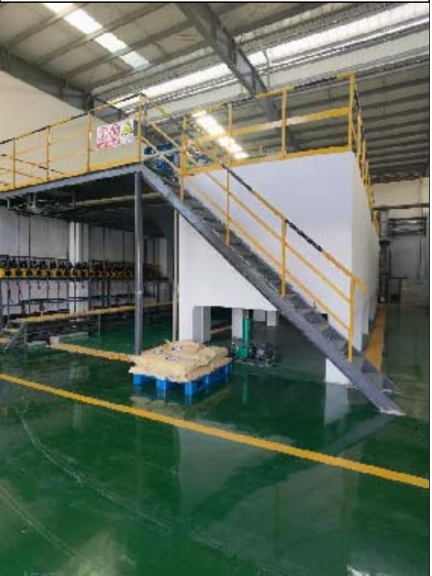
废水处理车间
