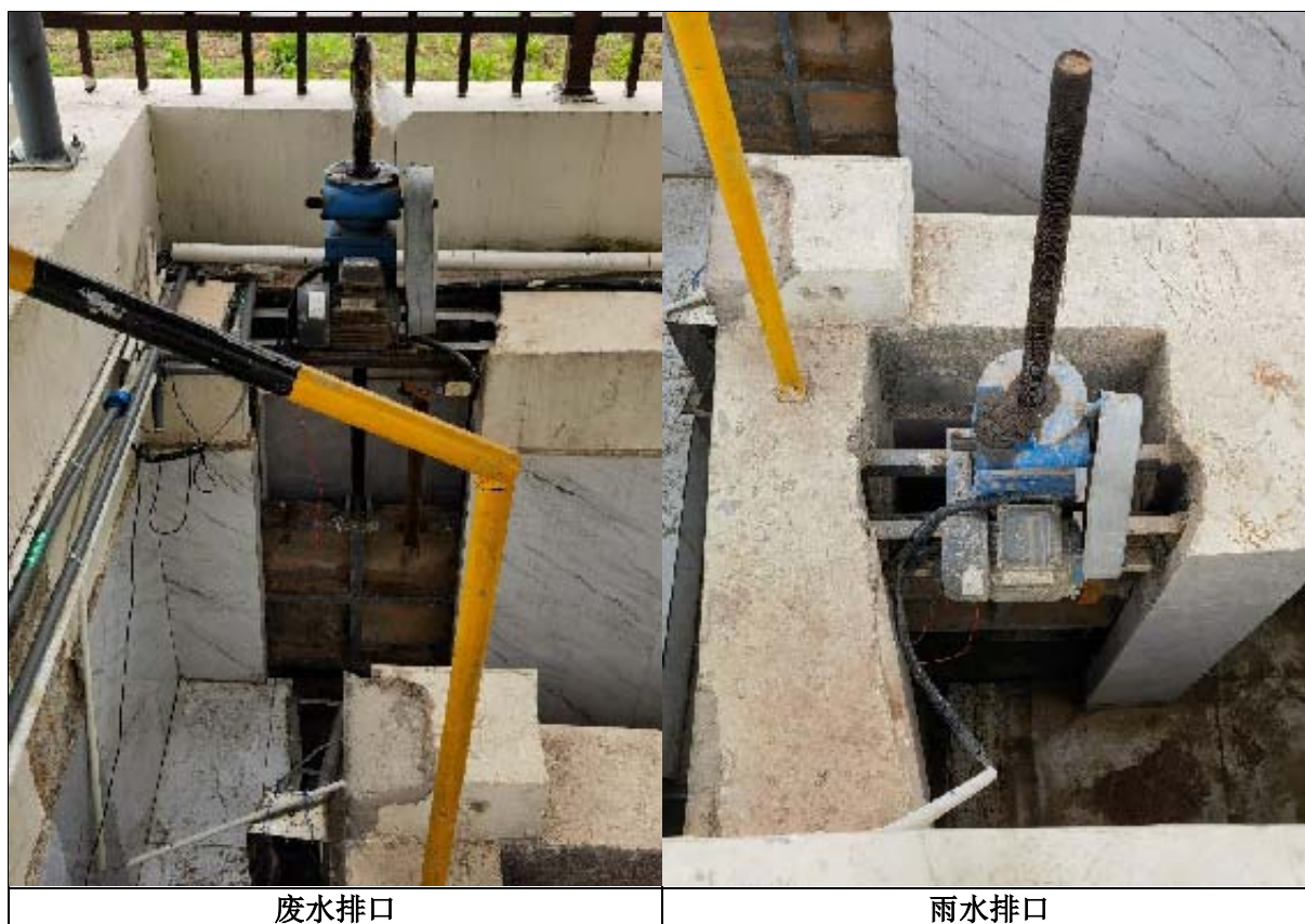
图 4.1-1 废水处理设施现场照片
