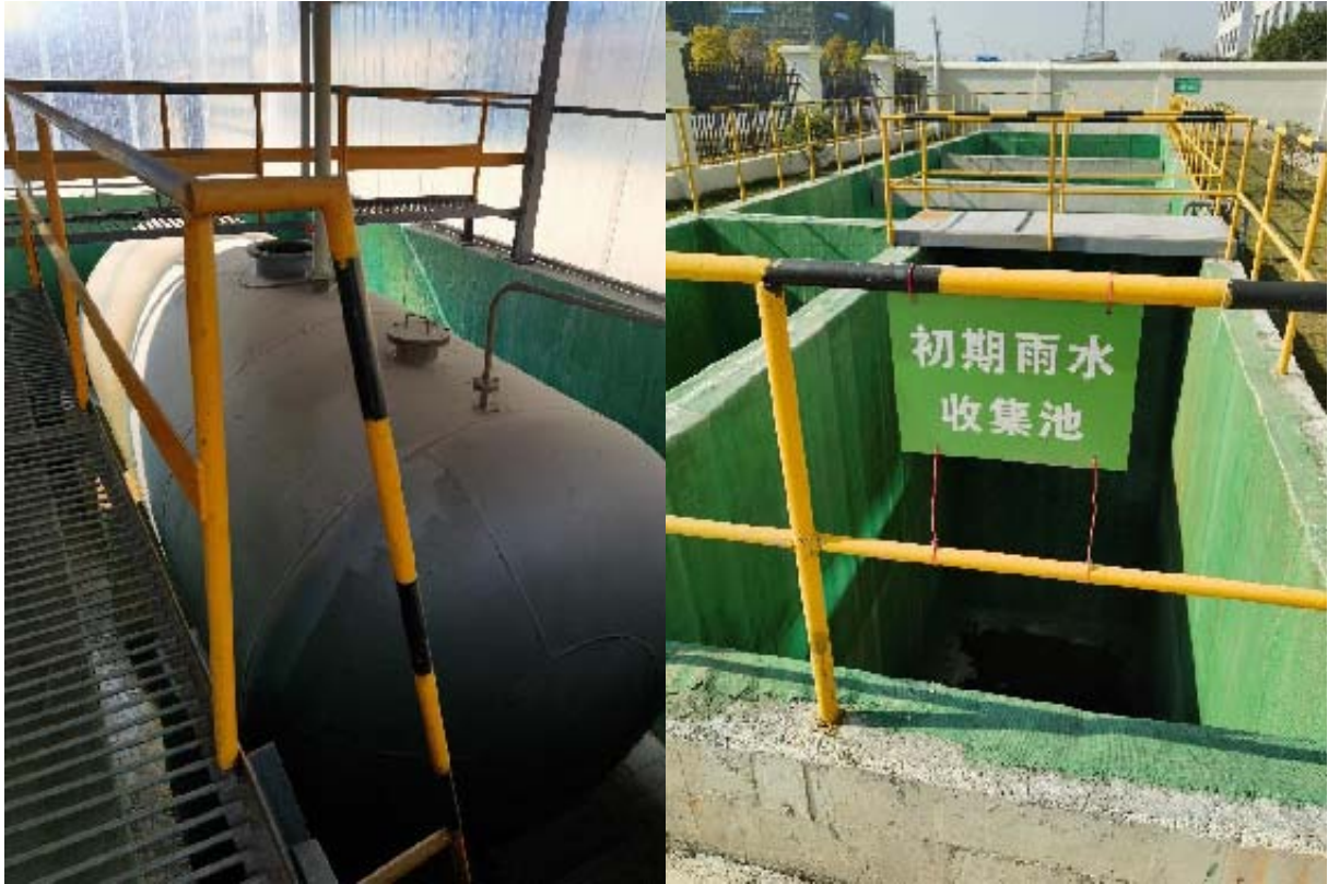
2#硫酸储罐区围堰
