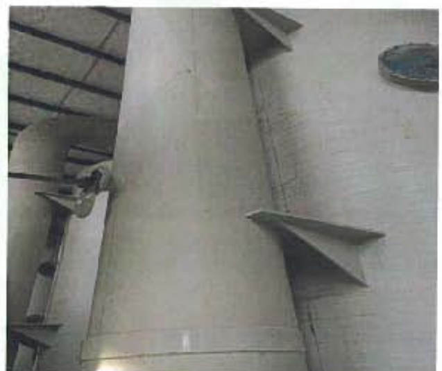
G4 酸性废气、有机废气治理设施处理后（三级碱 液喷淋塔后）DA002-2
