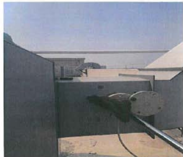
G12 实验室废气处理措施前 DA005-1
