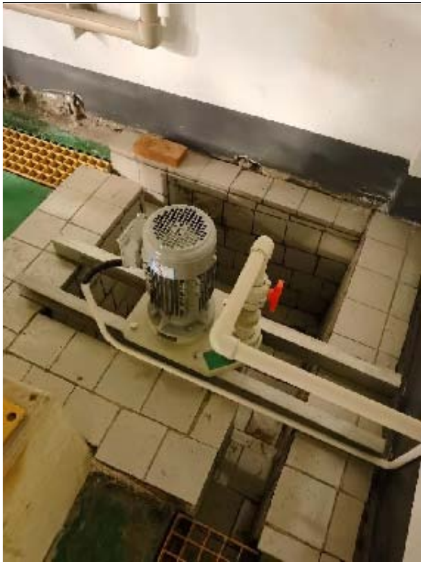
车间事故应急池
