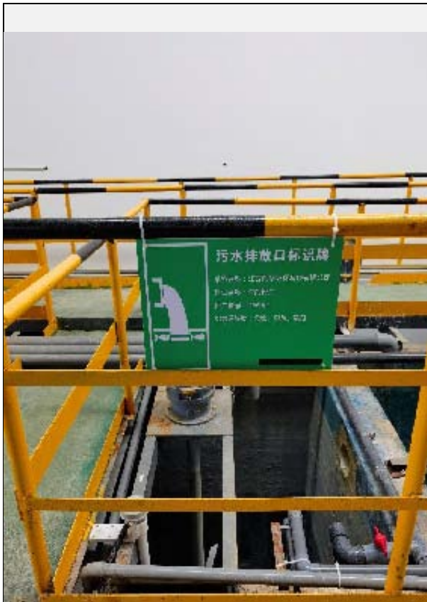
污水处理站-车间废水排口
