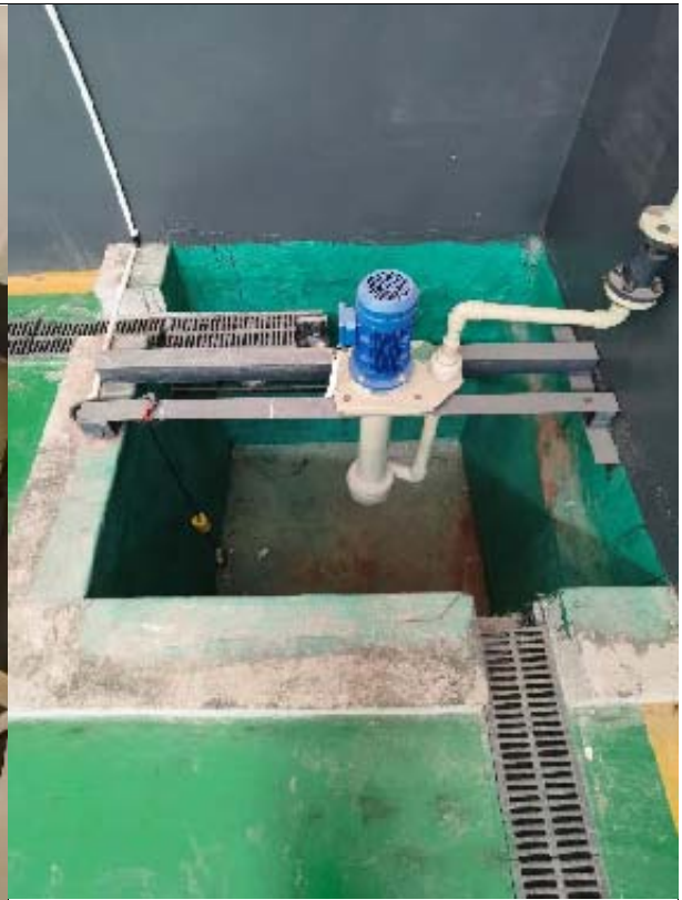
危废原料库渗滤液收集池
