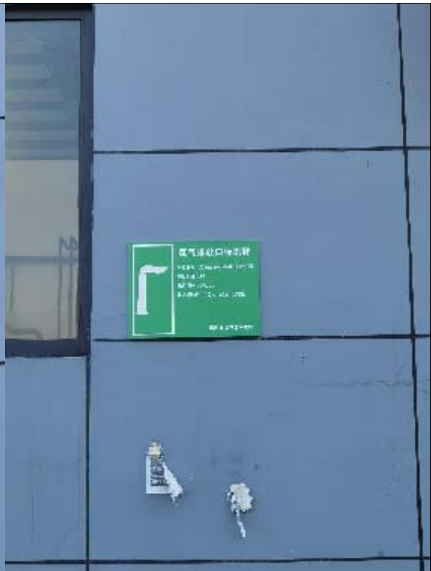
锅炉废气排放口
