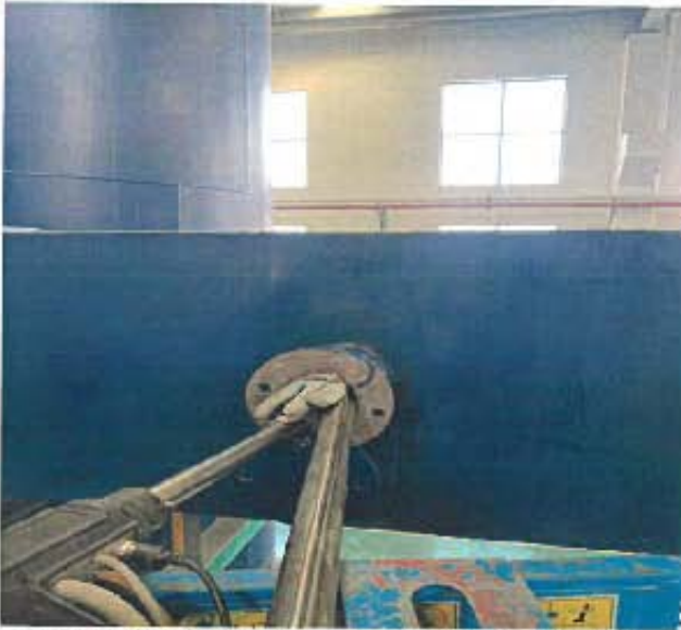
G1 预处理车间废气治理设施处理前（二燃室前） DA001-1
