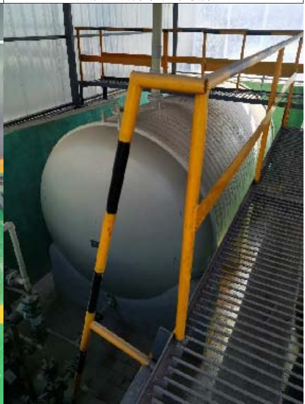
1#硫酸储罐区围堰
